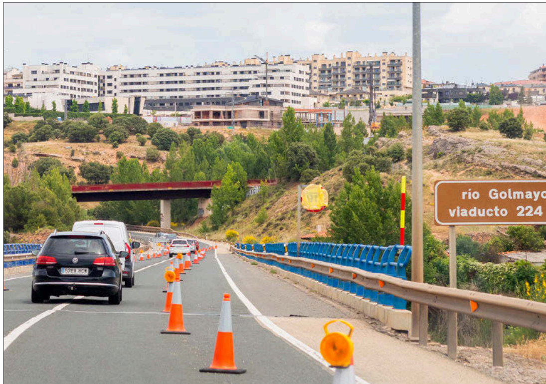
Vehículos atravesando el viaducto durante las últimas obras. MARIO TEJEDOR
